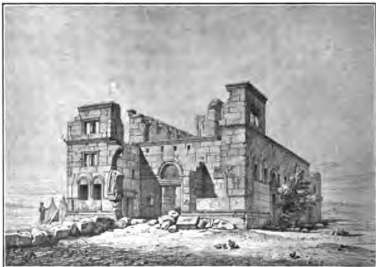
Fig. 2. — Église de Qalb-Louze (d'après Vogüé, Syrie centrale ).
